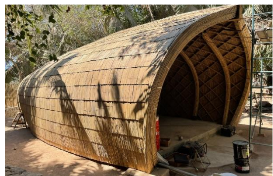
Ejemplo de construcción con esterillas de bambú
