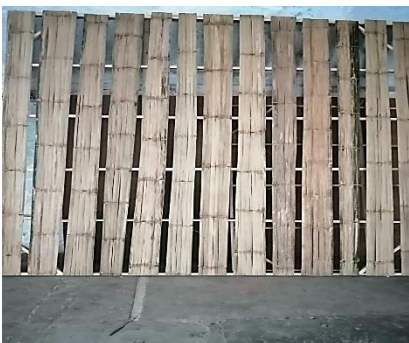
Panel de esterilla abierta y marco de madera
