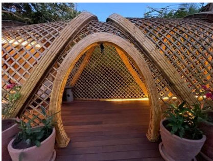
Estructura realizada con reglilla
